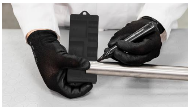
Image 22 - Marquage de la profondeur d'emboîtement
